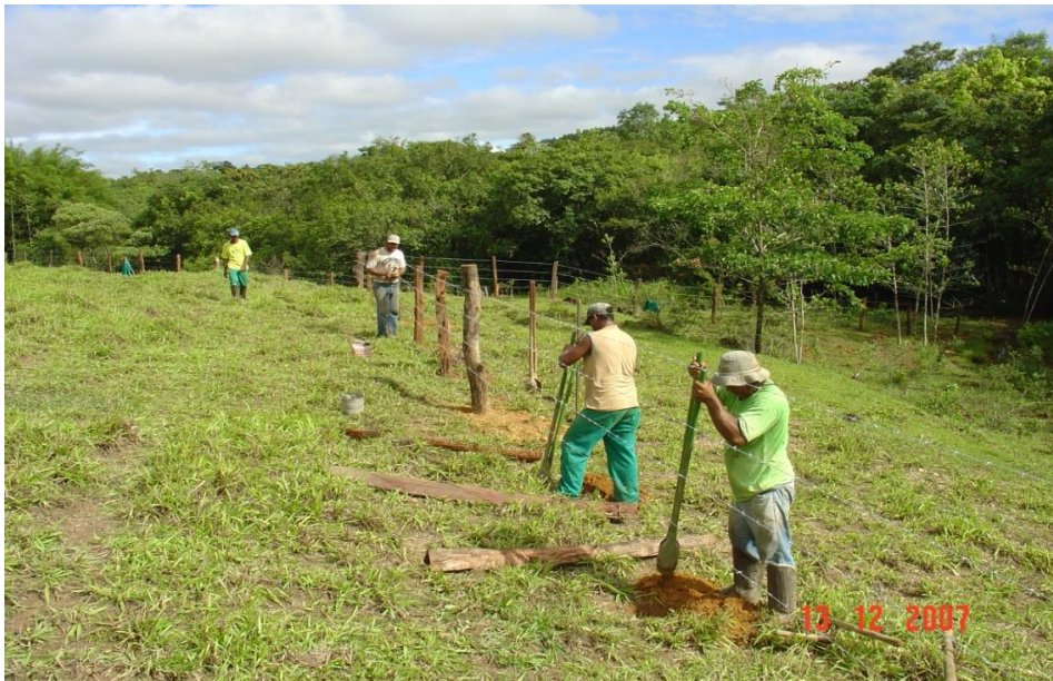
Foto 15: Construção de cercas na Microbacia do Córrego das Almas – Arcos – MG
