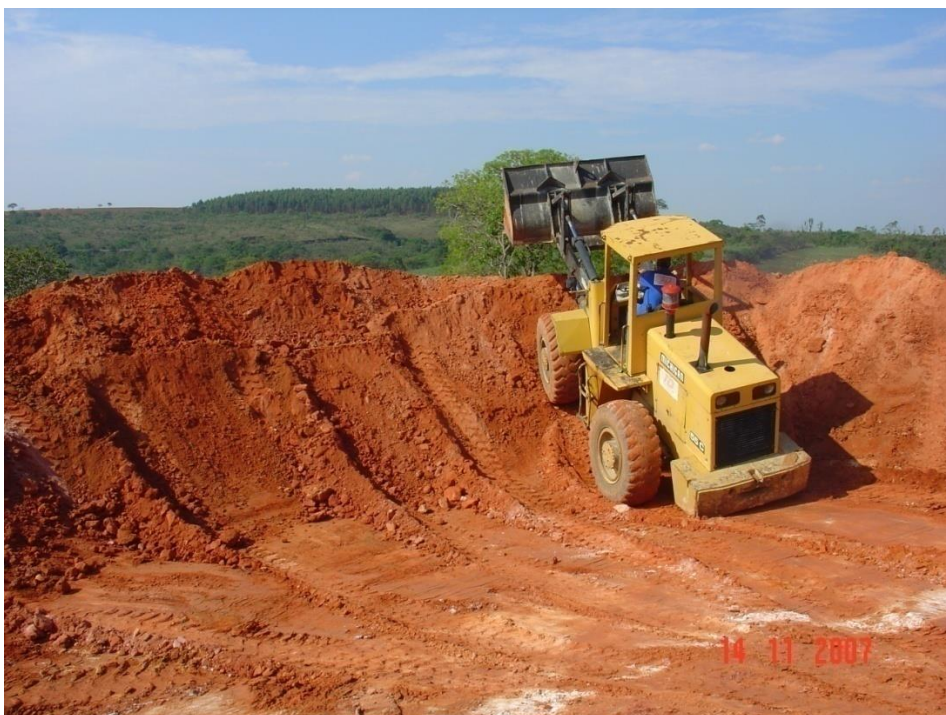
Foto 13: Equipe GOS Florestal atuando na Construção de barraginha na Microbacia do Córrego das Almas – Arcos – MG
