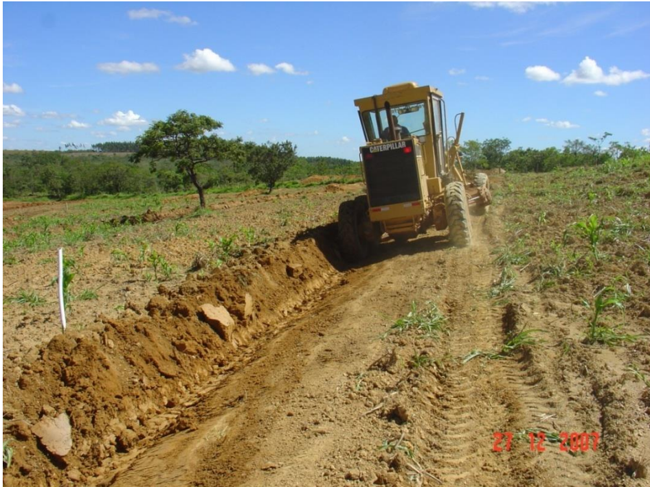
Foto 12: Equipe GOS Florestal executando trabalhos de terraceamento na Microbacia do Córrego das Almas – Arcos – MG
