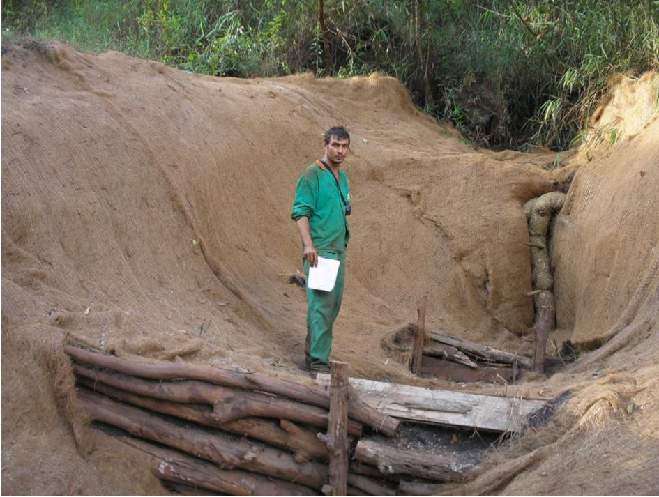
Foto 16: Controle de erosão com uso de paliçadas de madeira – Congonhas – MG
