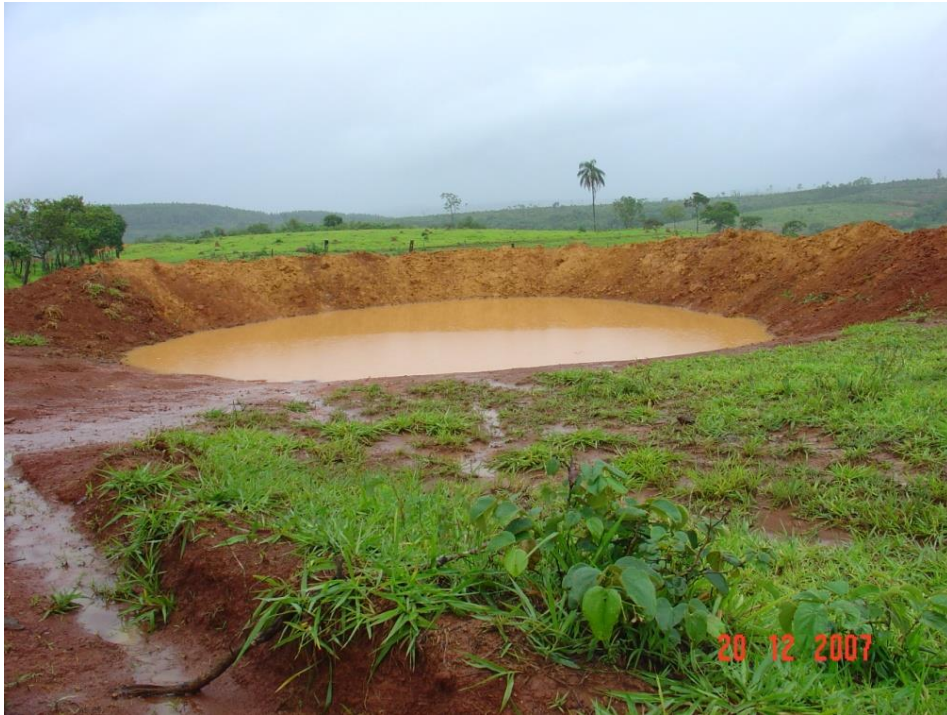
Foto 14: Barragem construída na Microbacia do Córrego das Almas – Arcos – MG
